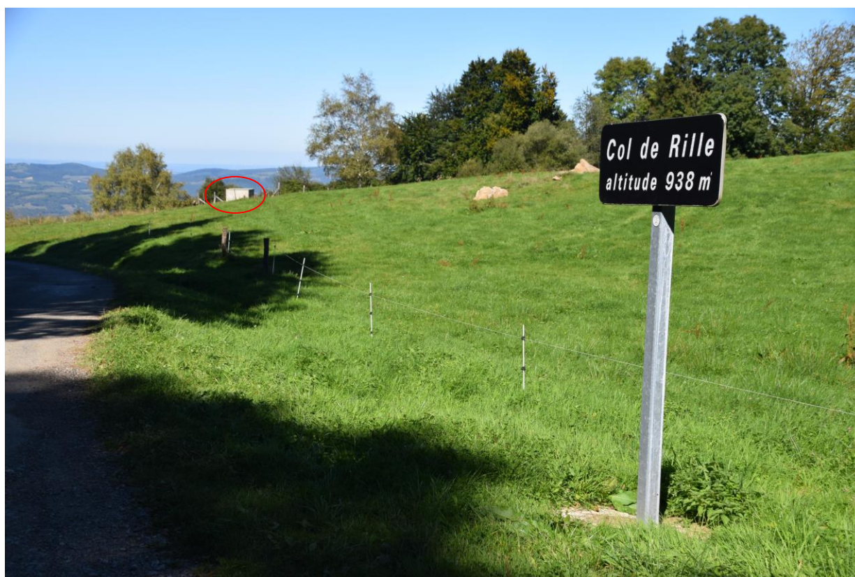
Illustration 5 : Cliché du réservoir de Rille depuis la voirie départementale
