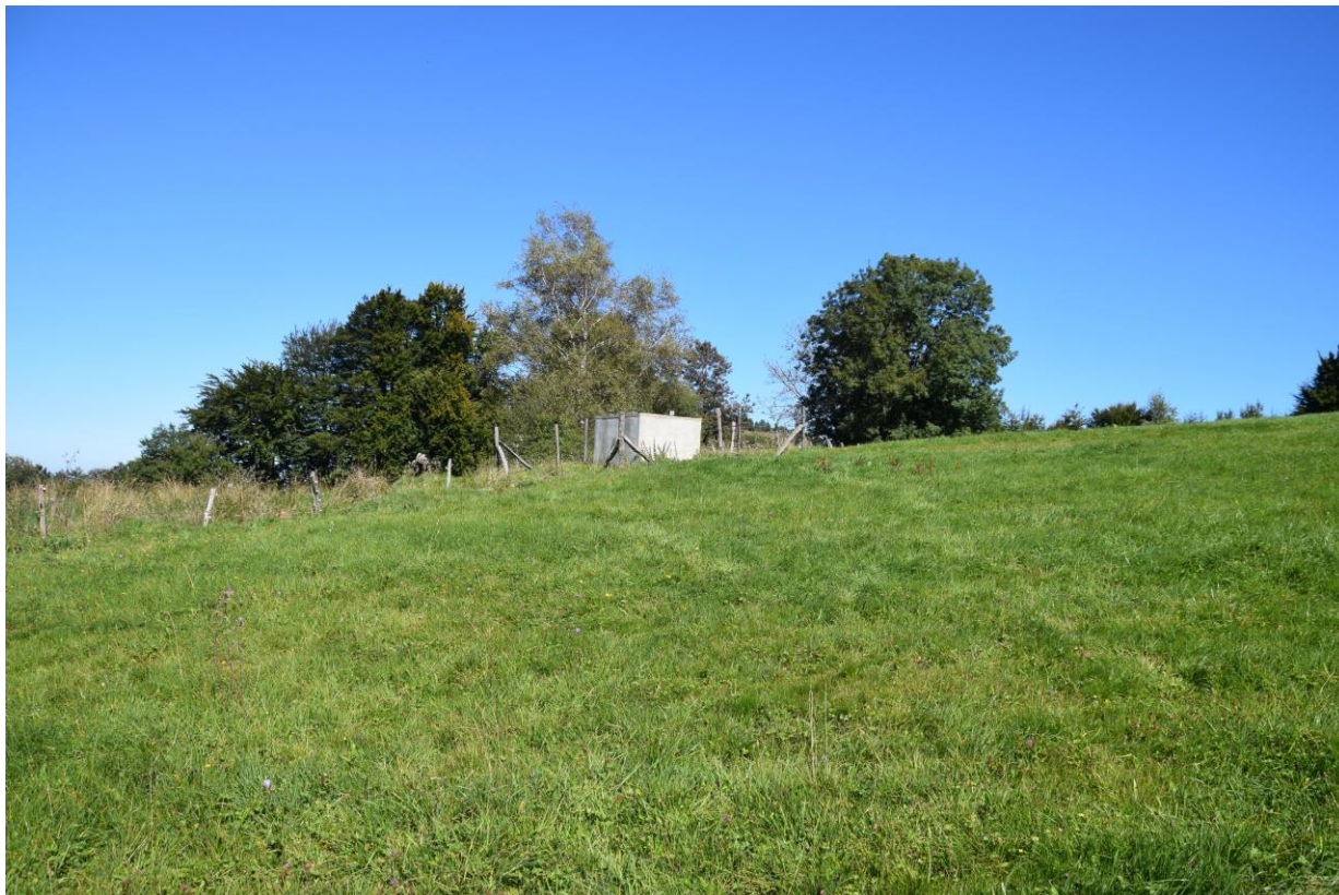
Illustration 6 : Cliché du réservoir de Rille depuis la voirie départementale
