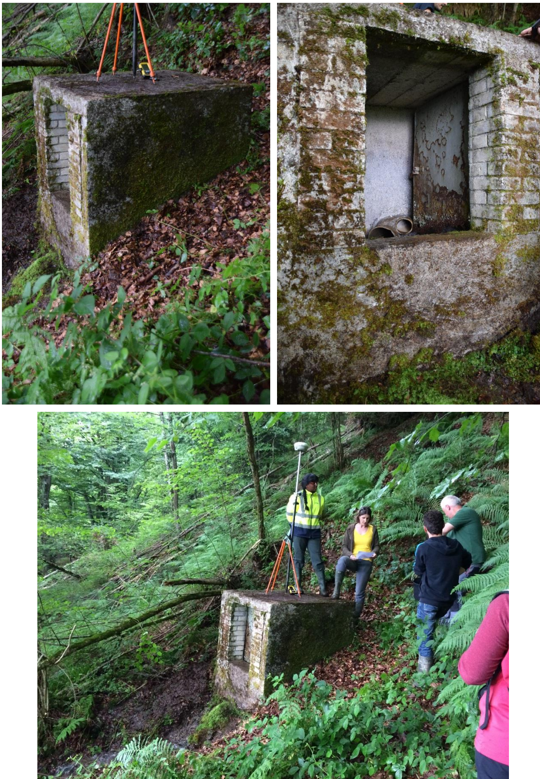
Illustration 16 : Clichés du captage de « Source de Rille »
